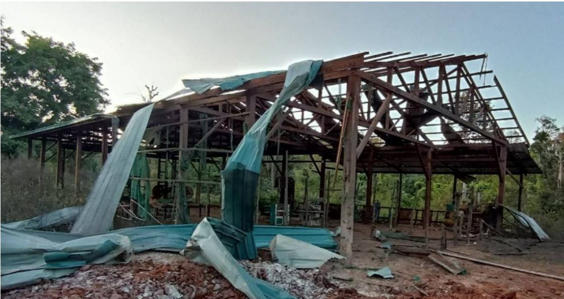
ဓါတ်ပုံ - ရိုးကီဗူးကျေးရွာမှ လေကြောင်းတိုက်ခိုက်မှုကြောင့် ပျက်စီးသွားသော အဆောက်အဦးတစ်ခု “အနာဂါတ်မှာ ဘယ်လိုရှင်သန်ရမလဲ” - ကရင်နီပြည်နယ်မှ ရက်စက်ကြမ်းကြုတ်သော ရာဇဝတ်မှုများ 49
